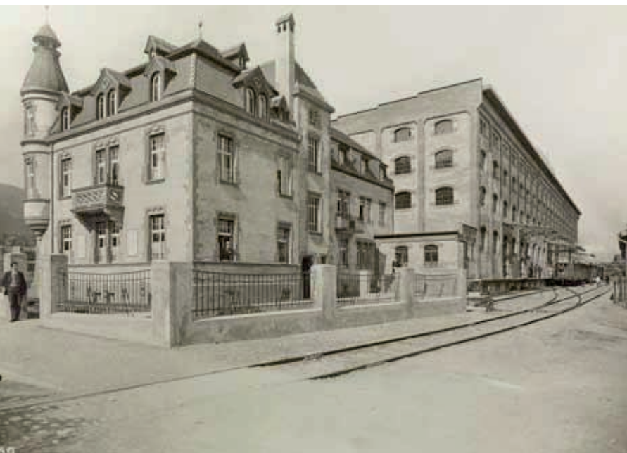
Lagerhaus der Zürcher Lagerhausgesellschaft in Zürich Giesshübel an Stadtrandlage mit Geleisanschluss (1909). Nachweis: ETH Hs_1085-1909-3-359.
