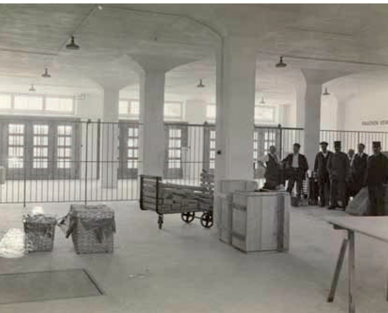
Imitierung von Nationalstaatsgrenzen im Zwischenraum: Verzollungshalle im Zollfreilager in Zürich-Albisrieden (1924–1925). Nachweis: ETH Hs_1085-1924-25-1_Foto_2.
