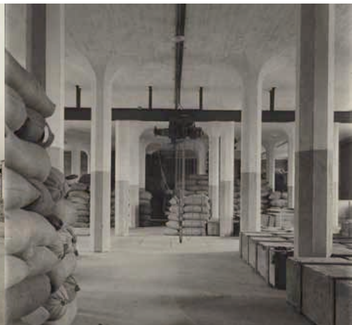
Warenlasten auf Pilzdecken in Hyperbelform im Lagerhaus Zürich Giesshübel (1909). Nachweis: ETH Hs_1085-1910-3-367.
