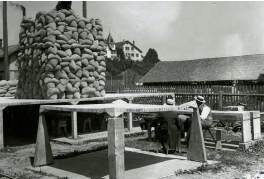
Probabauten für Belastungsproben auf dem Werkplatz der Firma Maillart & Cie (1908). Nachweis: ETH Hs_1085-1908-5-345, 4.
